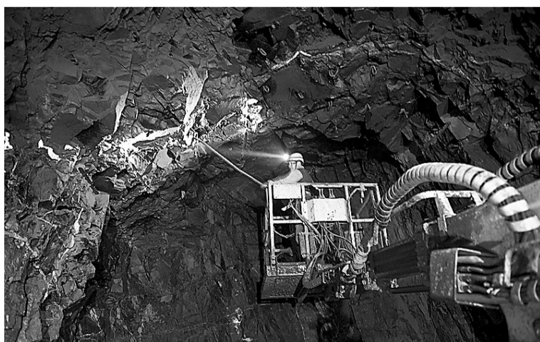
На руднике «Заполярный» выявлены многочисленные нарушения
